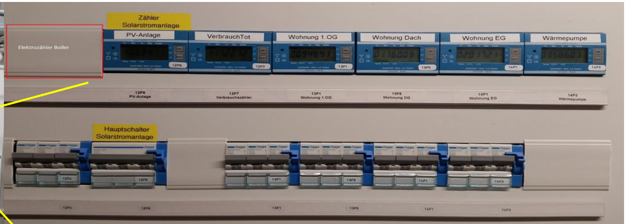
Zähler für Abrechnung und Monitoring
